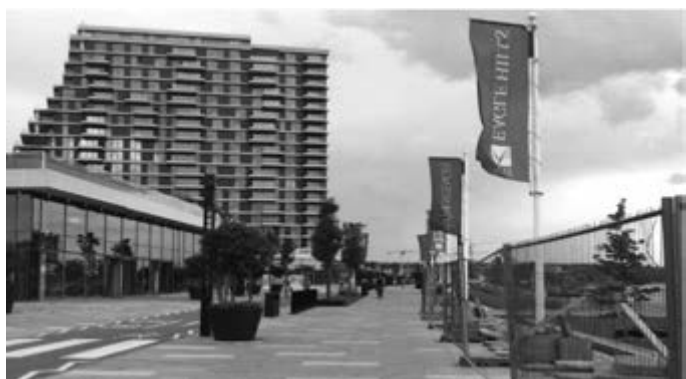
Фото:Н. Карлаш, Изградња пројекта „Београд на води”
